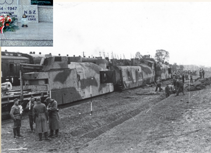
Niemieccy saperzy przy budowie objazdu wokół zniszczonego pociągu pancernego nr 52 „Piłsudczyk” w okolicach Mrozów, źródło: kolekcja prywatna A. Jończy
